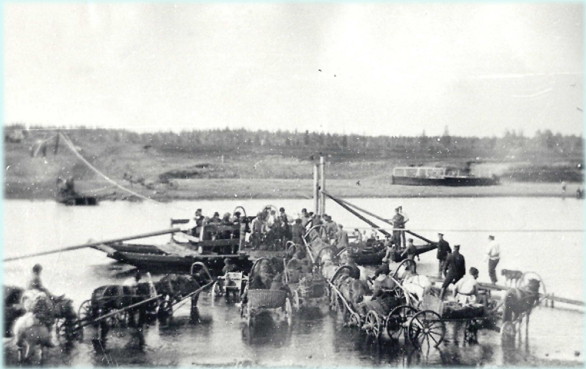
Паромная переправа через реку Чепцу.
